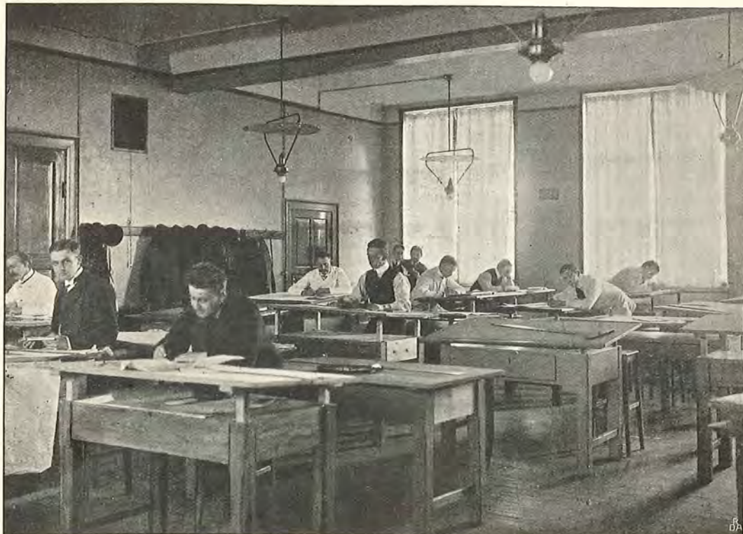
Fig. 32. Lokale for Maskinkonstruktion.
